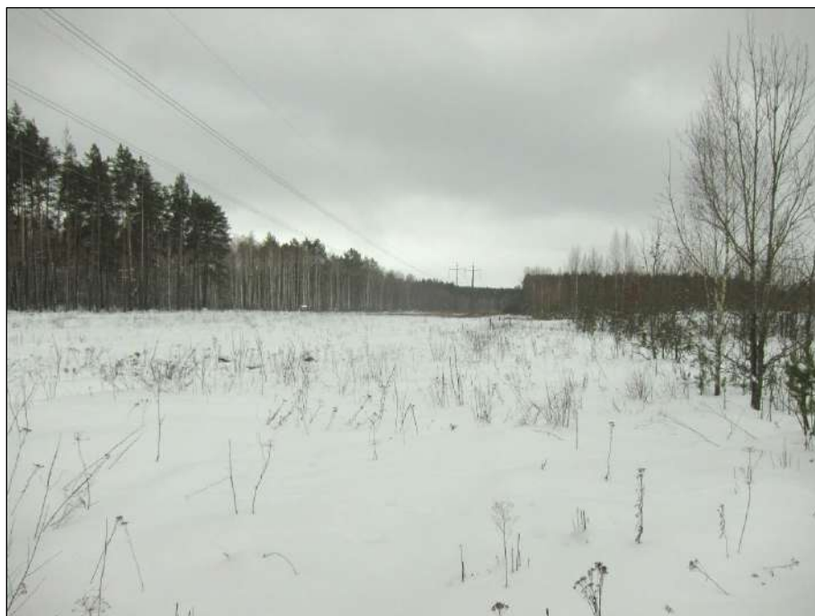
Рисунок 3.2 – ЛЭП в северной части обследованного маршрута
