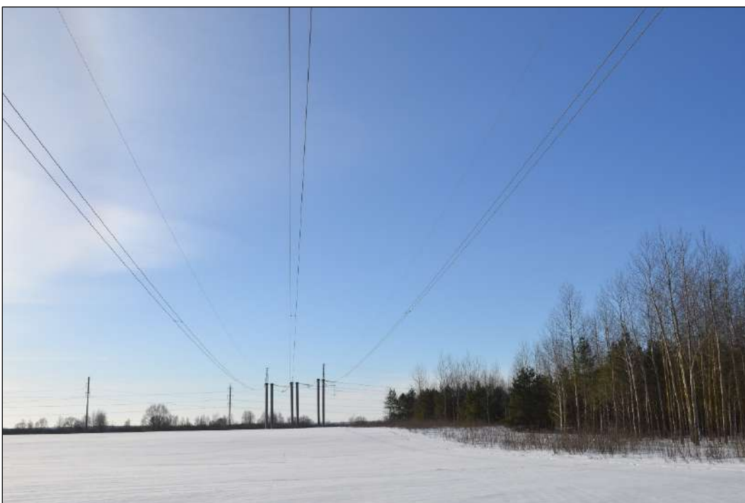
Рисунок 2.3 – Территория проведения реконструкции ВЛ на участке 2.
